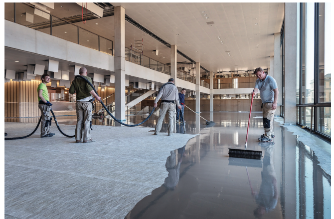
d'UZIN RR 201 avec UZIN NC 170 LevelStar, à l'aide de la technique de pompage.
