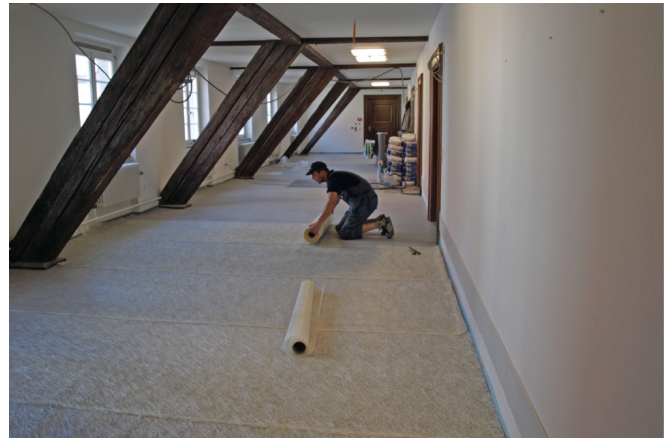
Lés d'UZIN RR 201 sur toute la surface à restaurer.
