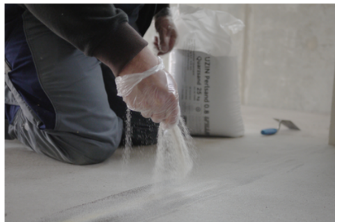
Racler et lisser la résine UZIN KR 516 encore fraîche, puis sabler à refus avec du sable siliceux UZIN Perlsand 0.8.
