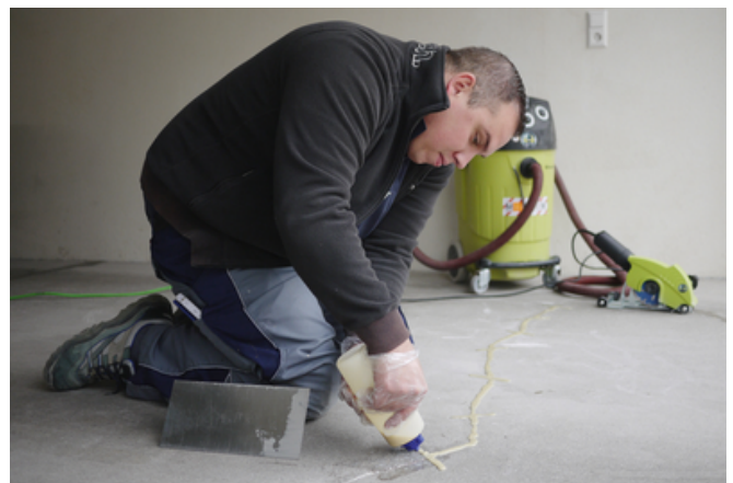
Après fraisage, dépoussiérage et mise en place des agrafes ondulées, verser la résine UZIN KR 516 dans le joint.
